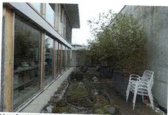
Hausfront und Gartenbereich Süd, Richtung Osten
