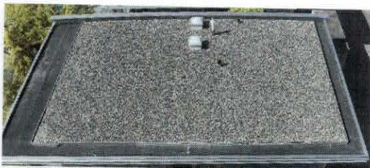
Flachdach mit Bitumen und Einkiesung
