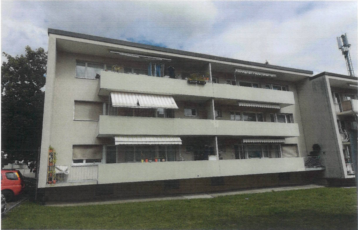
Wohnung 1. Obergeschoss West
