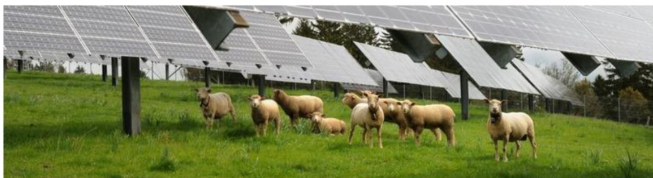
**Abbildung 12:** Anlage Mont Soleil, Schafherde verhindert das verwachsen der Modulflächen.
