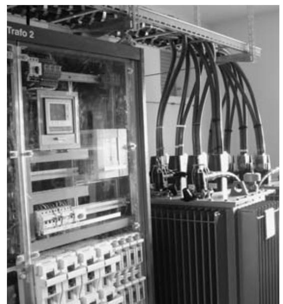
Bild oben vor dem Umbau und unten nach dem Umbau, berührungssichere metallgekapelte Anlage
